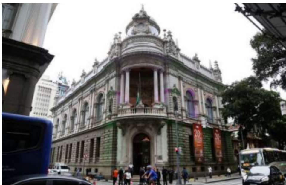
Foto da fachada do edifício do CCJE.
